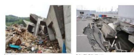
Gambar 2.24 Dinding beton bertulang yang rusak serta lantai bangunan yang terangkat (sumber Foto Otani, 2012)
