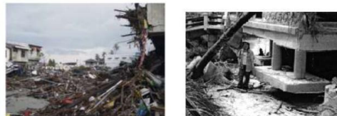
18 Kerusakan kolom sudut akibat pembendungan pui
