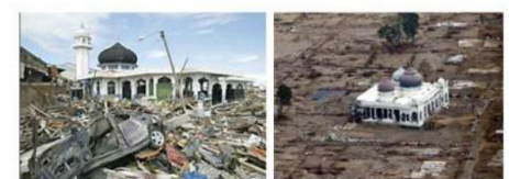
Gambar 2.15 Contoh bangunan mesjid yang bertahan di Banda Aceh karena dindingnya cukup terbuka
