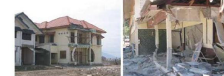
Gambar 2.17 Kerusakan kolom beton yang tidak direkayasa dengan baik akibat hantaman puing-puing
