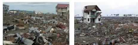
Gambar 2.14 Contoh bangunan beton bertulang yang bertahan di Banda Aceh
